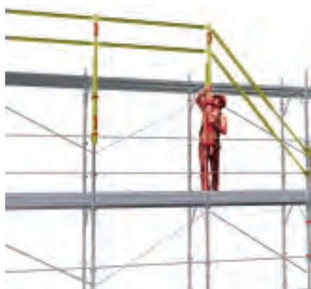
Eurosafe permette di realizzare sui ponteggi tubolari, un parapetto provvisorio, necessario per la sicurezza dei montatori, durante le fasi di montaggio e smontaggio.
