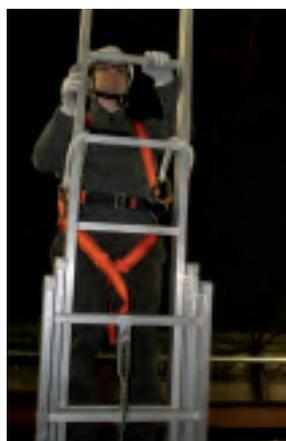
L'operatore, raggiunta la postazione di lavoro sulla scala, si vincola ad essa facendo passare i cordini attorno ai montanti e agganciandone entrambe le estremità agli anelli della cintura di posizionamento.
