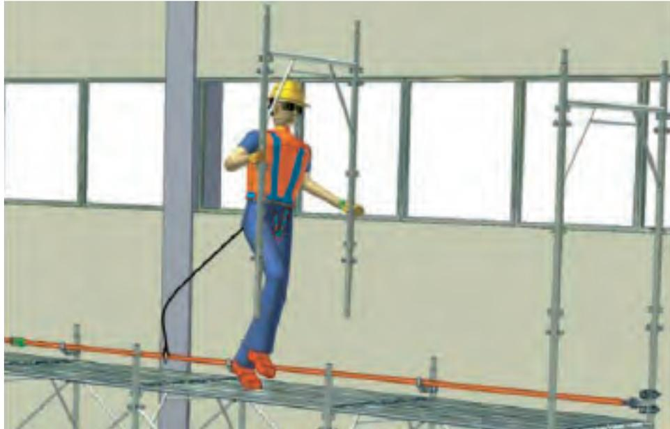
**A - Ponteggio con telaio di tipo a perni**
