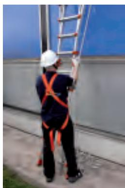
AVVICINARE LA SCALA A PIOLI ALLA CORDA. COLLEGARE L'IMBRAGATURA ALLA CORDA TRAMITE IL DISSIPATORE.
