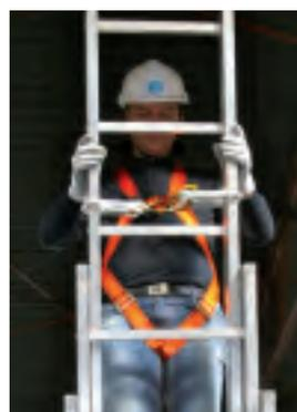
L'operatore, raggiunta la postazione di lavoro sulla scala si vincola ad essa facendo passare i cordini attorno ai montanti e agganciandone entrambe le estremità alle asole del punto di ancoraggio dell'imbracatura.
